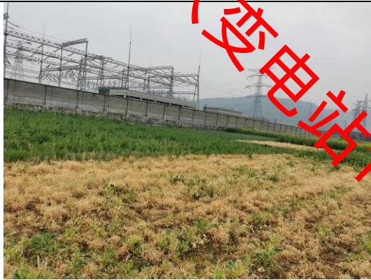
元墩330kV变电站110kV出线侧
